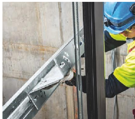
Unir el conector de carril con el perno en T en el canal C.
