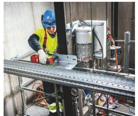
Asegurar los pernos después del ajuste final.
