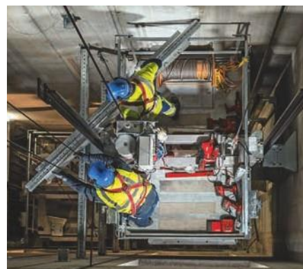
La viga de peso ligero puede ser movida por una sola persona.
