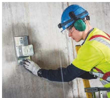
Los conectores en U sostienen con seguridad las vigas sin sujetadores.
